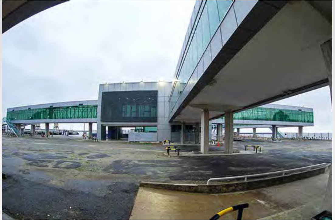
Pasarelas de acceso, de la Terminal de Pasajeros de Puerto Colonia
